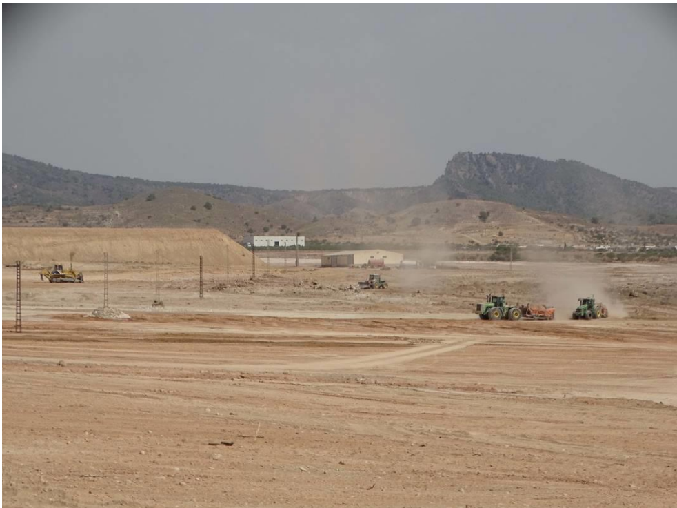
Imagen 11. Maquinaria trabajando en la roturación y construcción de embalse junto a la población de La Murta (agosto de 2017) Fuente: P.García/ANSE
