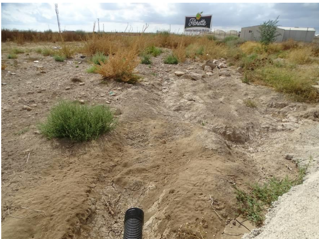
Imagen 25. Cauce de rambla relleno aguas arriba de los invernaderos. Fuente: P.García/ANSE.
