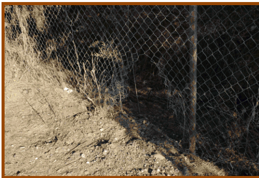
(Foto: roto en el vallado perimetral de la A-4)
